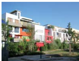
Immeuble artisanal à Vauban, Fribourg-en-Brigau (Allemagne)
