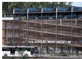
«Solargarage» à Vauban, Fribourg-en-Brisgau (D)
