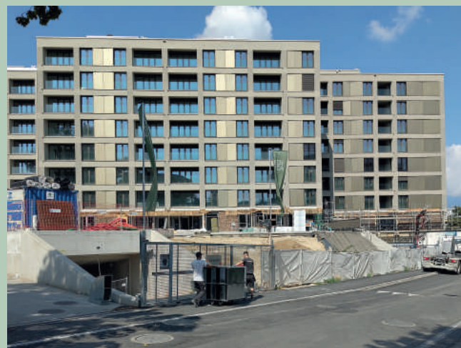
Vue du chantier de Concorde secteur L, rue Jean-Simonet, juillet 2025
