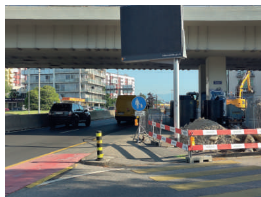
Chantier de l'avenue de l'Ain, juin 2025
