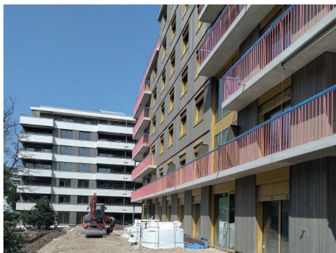
Vue du chantier au chemin du Croissant, juin 2025
