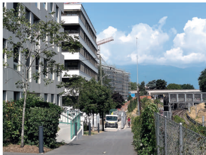
Emplacement de la future voie verte, de l'avenue Henri-Golay à Concorde Espace Culture
