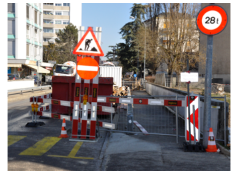
signalisation de chantier au pont de l'avenue Henri-Golay en 2019.
