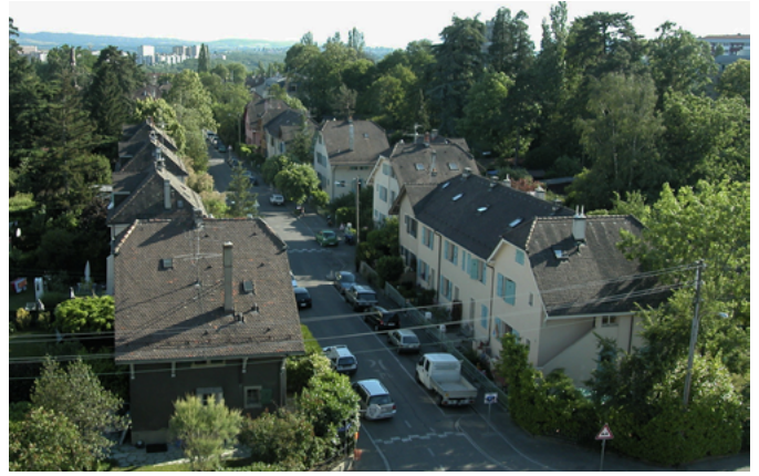
Cité-jardin Nouvel-Aire, réalisée par une fondation de l'Etat de Genève pour 70 logements, est encore présente dans son entier. Mais dans le cadre du PDQ, 12 maisons seront démolies entre les avenues de la Concorde et d'Aire en 2022.
