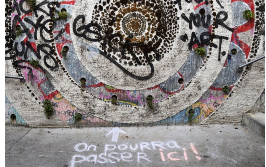
Mur de soutènement végétalisé du passage côté Libellules.
