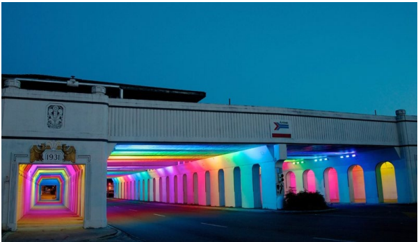
Eclairage (Birmingham, Etats-Unis)
