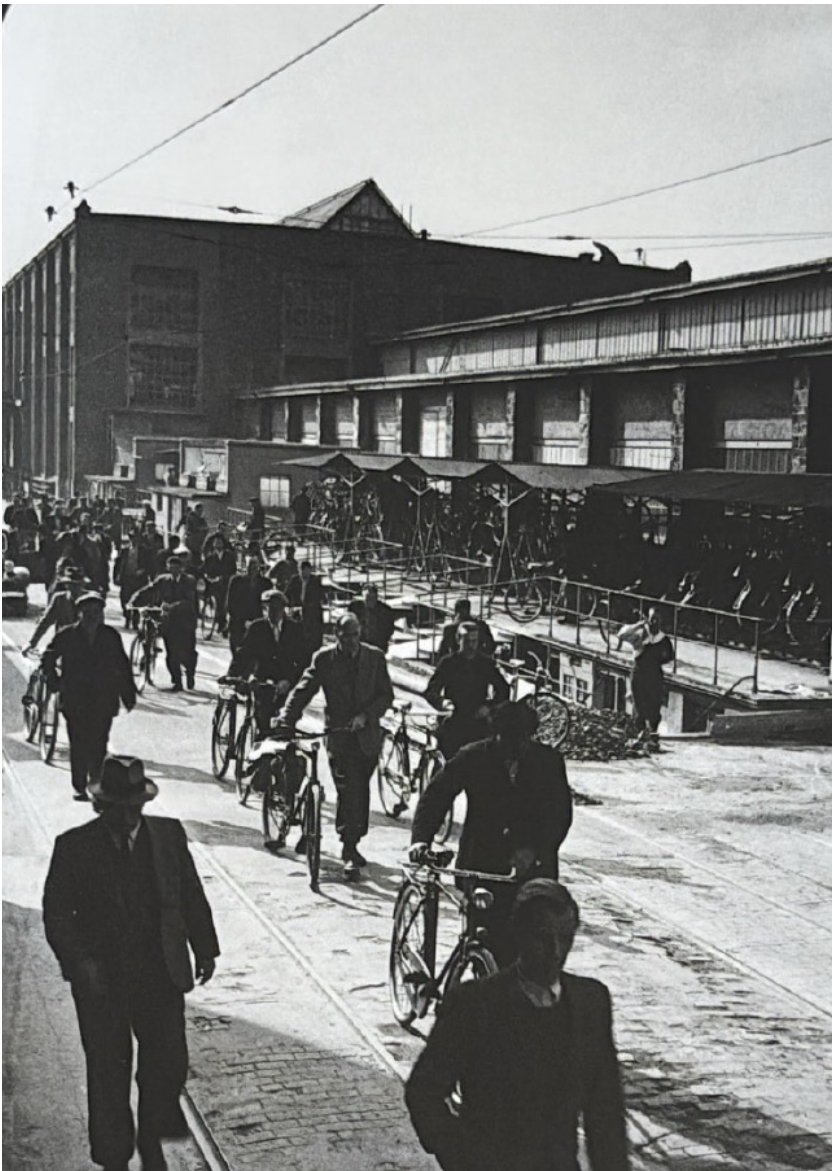
Fig. 2.2.3 - Ouvriers sortant d’une usine des Charmilles
