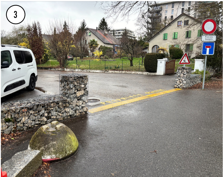
Fig. 2.4.9 - Le sas d'entrée de Coin de Terre
