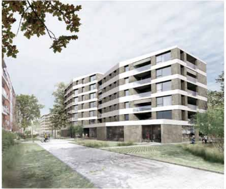
Vue de l'extérieur - emplacement du bâtiment à Genève
