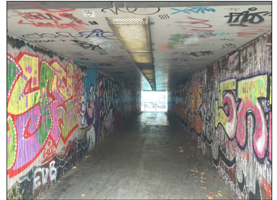
Vue du passage coté quartier Libellules
