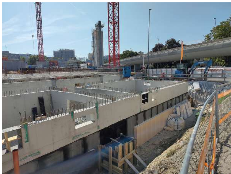
Vue du chantier en septembre 2024
