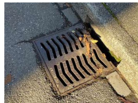
Une bouche d'évacuation des eaux de pluie à l'avenue de la Concorde
