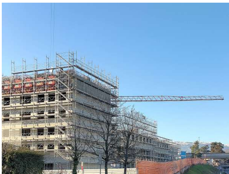
Vue du chantier à mi-décembre 2024
